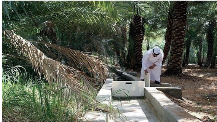
[شكل 8 - صور توضيحية معاصرة عن طريقة التحكم بكمية الماء المار للري في الأفلاج كما وصفها الرازي]. ولاية العين-الإمارات 24 .
